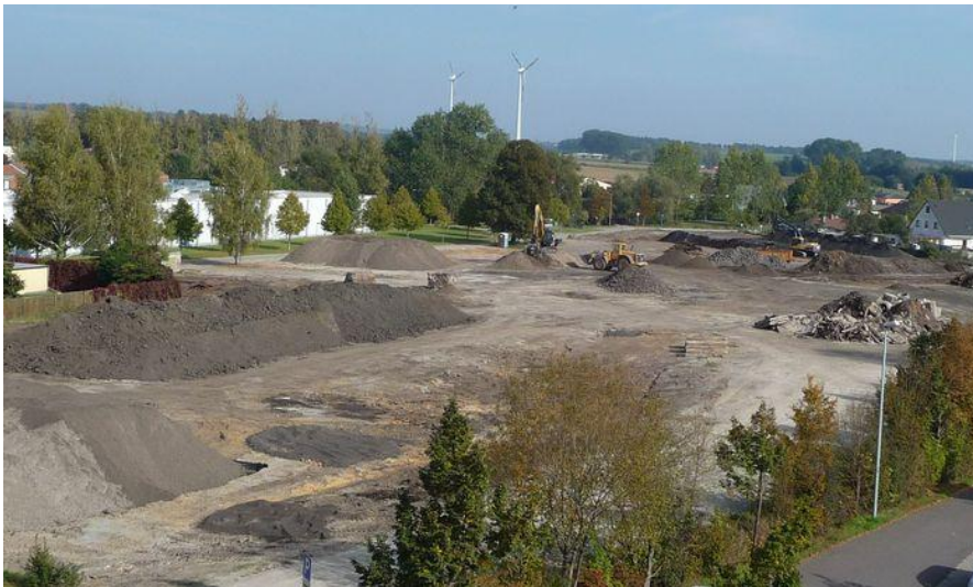
Das Baufeld ist vorbereitet. Hier ein Blick auf die Arbeiten im November / Dezember 2015 Foto Kreisverwaltung Börde).
